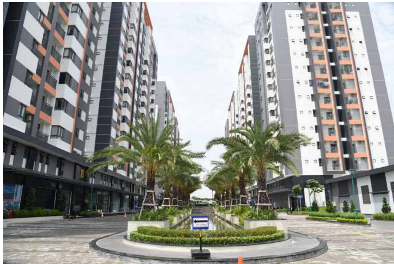
Dự án Him Lam Phú An (Quận 9, TP. Thủ Đức)
